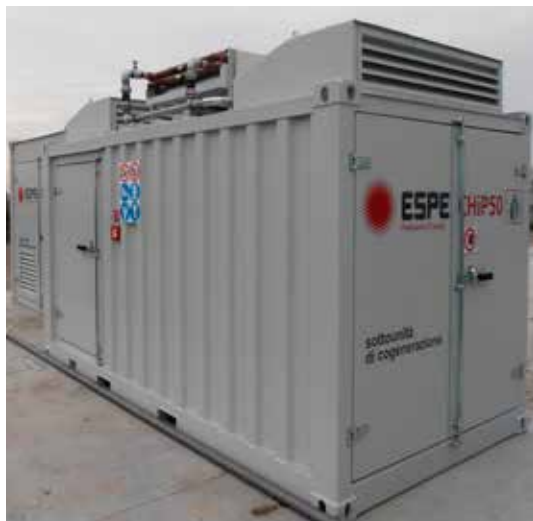
Impianto di cogenerazione da 49 kW elettrici e 110 kW termici Azienda agricola ortofrutticola - Sermide (MN)
